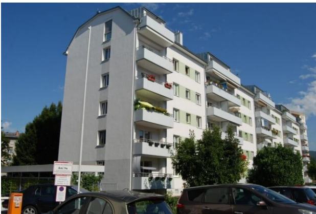
Hausansicht Pragerstraße Süd
