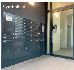
Die Hausbriefkastenanlage inkl. Paketablagebox wird entweder in einem witterungsgeschützten Bereich vor der Haupteingangstüre oder in Kombination mit dieser montiert. Das Klingeltableau und die Gegensprechanlage mit Videosprechstelle werden im Nahbereich der Haupteingangstür situiert.
