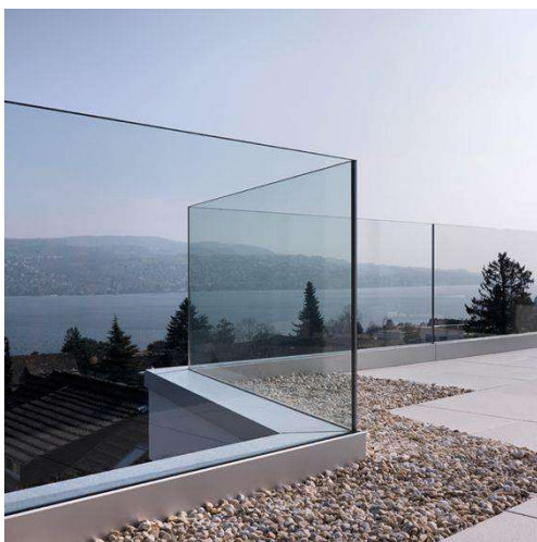
Brüstung Terrasse & Balkone Material: VSG Glas
