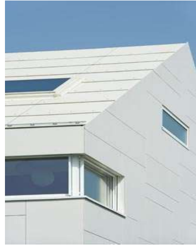
Dachfläche Material: ETERNIT INTEGRAL Großformat Farbe: weiß P 111
