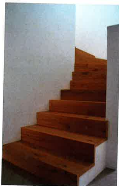
Betontreppe mit Parkettverkleidung
