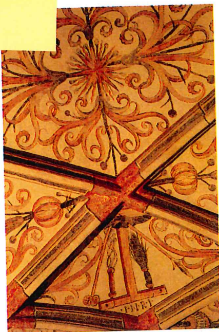
F 30 Renovierte Rankenornamentik (1476) und Netzrippengewölbe der Unterkirche von St. Leonhard
