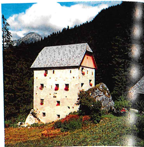
F 31 Renovierter Pflegturm bei Spital am Pyhrn
