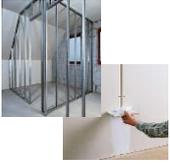
Diese werden als Gipskartonständerwände in den Wandstärken gemäß Zeichnung mit innenliegender Schalldämmung tapezierfähig (Q3) verspachtelt erstellt. In Bädern werden zwei Lagen Feuchtraumplatten zur Beplankung der Ständerwände verwendet.
