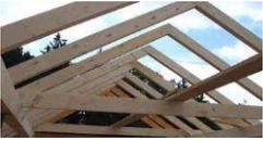
Die Dachkonstruktion wird aus Nadelholz hergestellt und mit allen erforderlichen Verbindungsmitteln fachgerecht aufgerichtet. Die Holzabmessungen ergeben sich aus den statischen Erfordernissen. Der Dachüberstand beträgt ca. 50 cm. Die Untersicht besteht aus einer gehobelten Nut-Feder-Schalung. Eine waagrechte Dachschalung gilt nicht als vereinbart.
