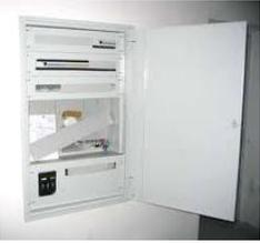
Um eine sichere und ausreichende Stromversorgung zu gewährleisten, baut der Auftragnehmer 10 Stromkreise mit einem Fehlerstromschutzschalter in das Haus ein. (inklusive Prüfbericht). Der Elektroherd, die Geschirrspülmaschine, die Waschmaschine, der Wäschetrockner erhalten jeweils eigene Stromkreise. Die verbleibenden Stromkreise werden für Lichtauslässe und Steckdosen aufgeteilt.
