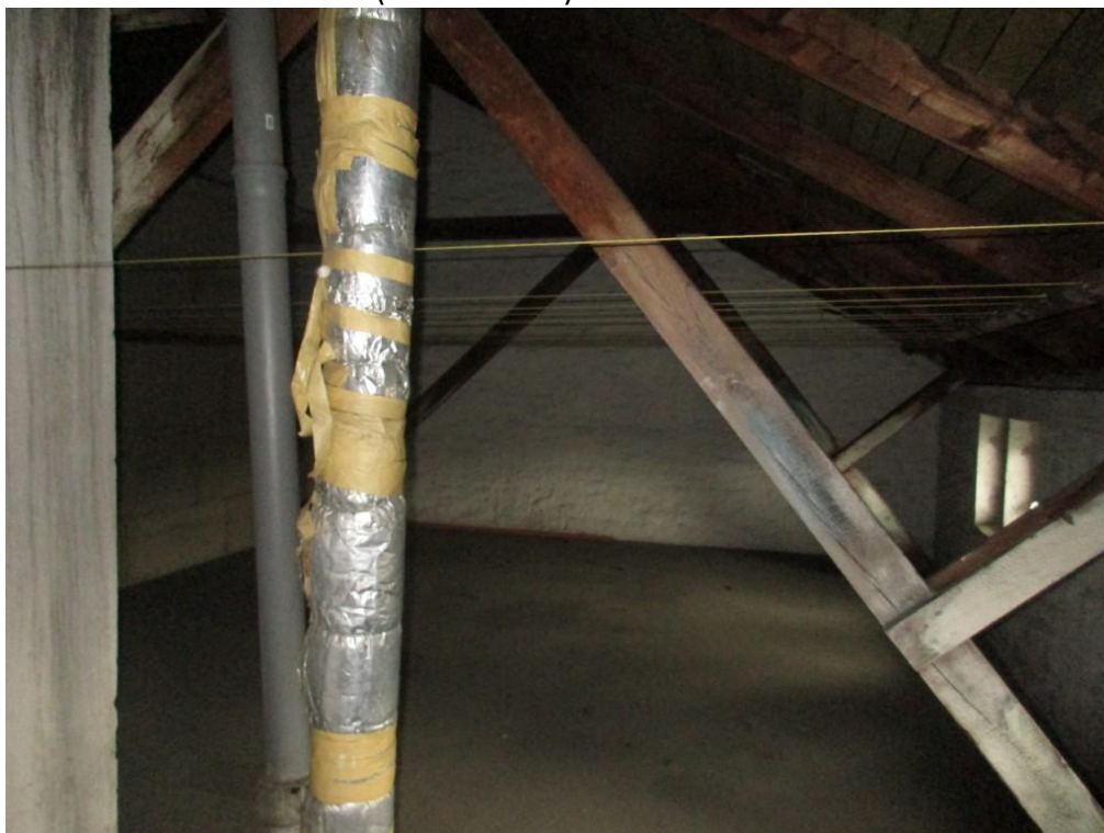
Dachraum über der W 16 (nicht isoliert):
