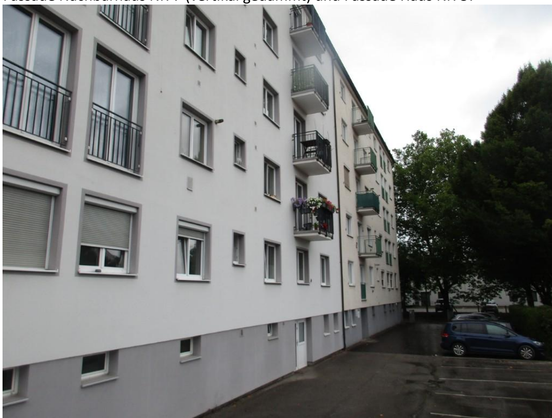
Fassade Nachbarhaus Nr. 7 (vertikal gedämmt) und Fassade Haus Nr. 5:
