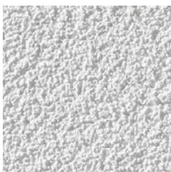
Vollwärmeschutz, Verputz Farbe Weiß (Symbolfoto)
