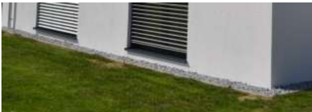
Spritzwasserschutz mit Granitbruch
