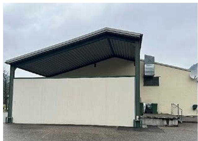
Lagerhalle mit Flugdach und Rampe
