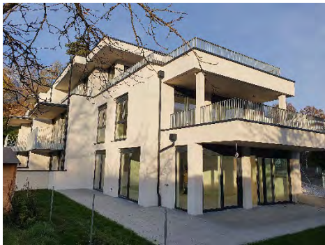
Wohnanlage Reimmichstraße 13, Hall
