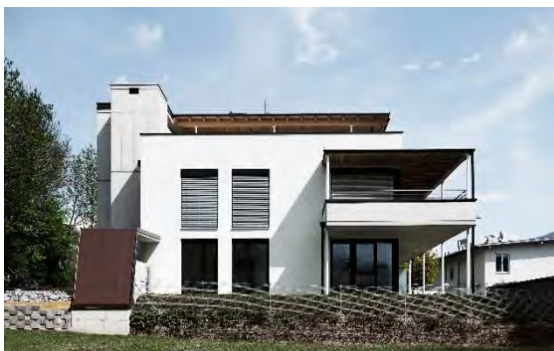
Wohnanlage Dörfer Straße, Absam
