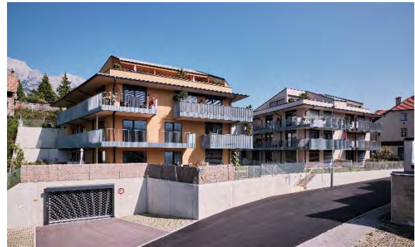
Wohnanlage Reimmichstraße 2, Hall
